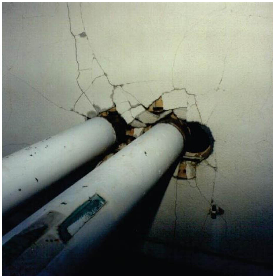
איור 2-6.4.3.5 – פגיעה של קיר עקב הזזות אופקיות של צינור שלא עוגן כראוי.
