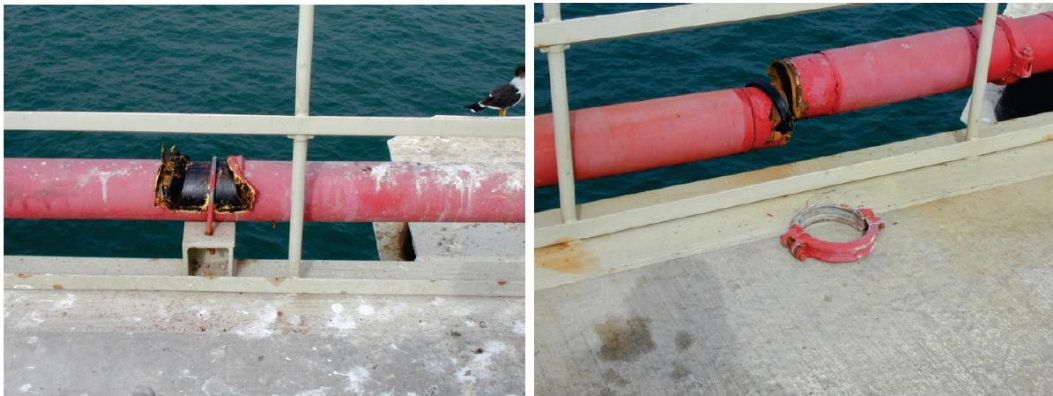
איור 6.4.4.1-6 – נזק לצנרת כיבוי אש תעשייתית. מצד ימין – כשל במחבר להצמדת צינורות ומעיכת הצנרת; מצד שמאל – החלקה בכיוון האורכי במחבר U הנותר שלם, אך המחברים האחרים נשברו ונפלו.
