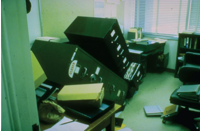
איור 2-6.5.5.1 – נזק לציוד משרדי עקב רעידת אדמה.
