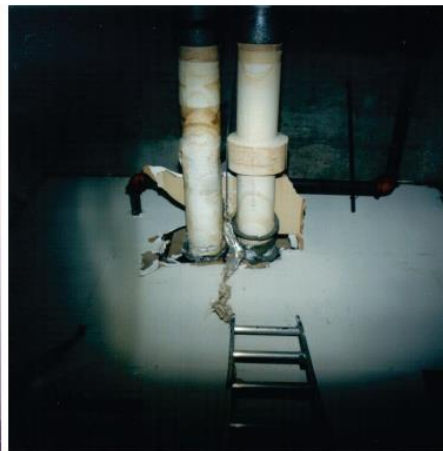
איור 1-6.4.3.8 – נזק שנגרם לתקרות, מחיצות גבס, מגן אש ובידוד. שימו לב כי בצנרת הכחולה נוצרה דליפה שגרמה לנזק נוסף באזור החדירה.
