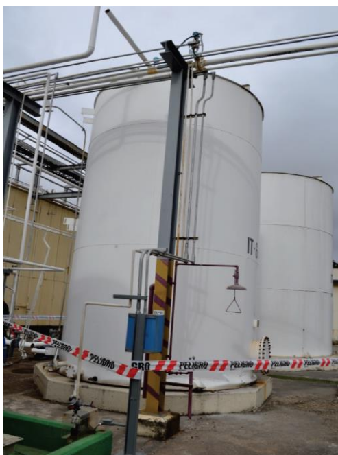
איור 3-6.4.5.1 – נזק למיכלי דלק שעוגנו באופן לקוי שגרם לפגיעה בקווי אספקת הדלק. תמונת התקריב מציגה כשל בצינור באזור מחבר מרוחק (משמאל) ומקטע צינור עם שסתום מחובר (בחזית) שנתלש מתוך המיכל.
