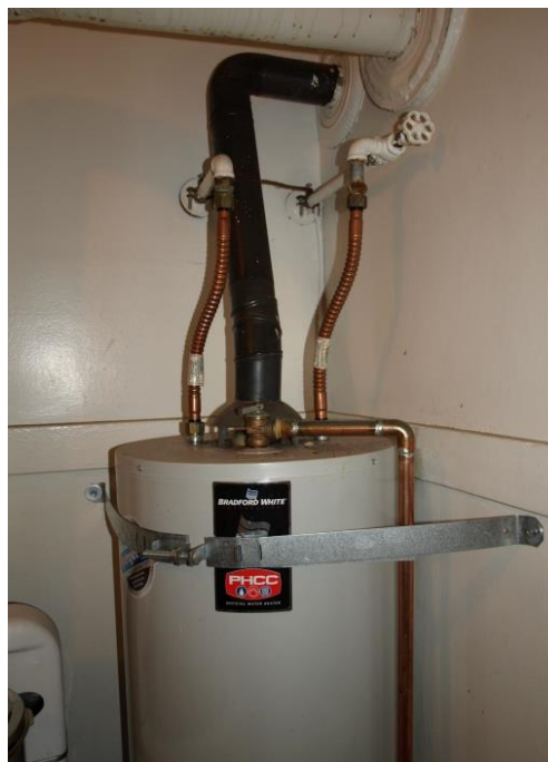
איור 6.4.2.4-4 – שימוש ברצועה לעיגון דוד מים בפינה, מחברי הצינורות גמישים מנחושת.
