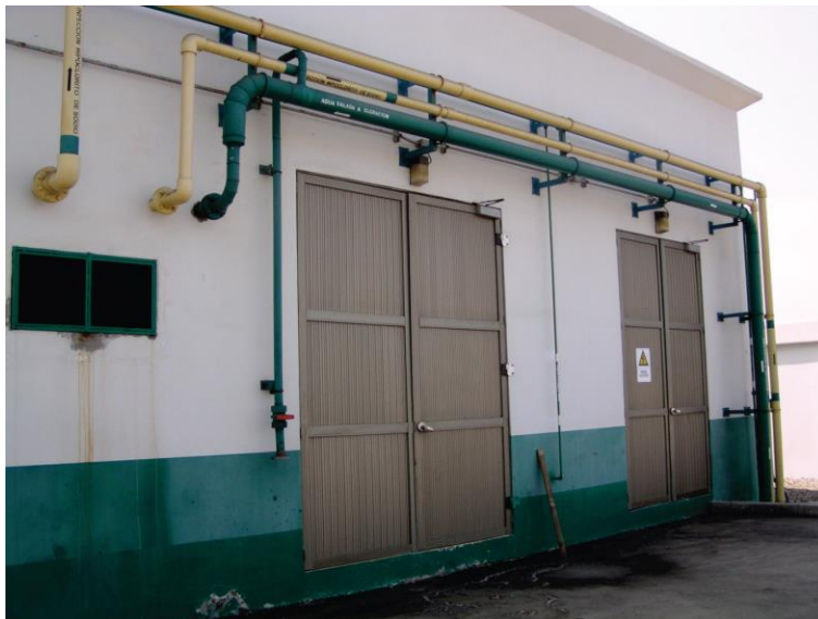
איור 6.4.3.7-1 – עיגון צנרת אופקית ואנכית לקיר חיצוני. ניתן לראות כי נוצר נזק קל לצנרת הירוקה החודרת לקיר וכי המחברים הוסטו קלות, אך העיגון תפקד טוב באופן כללי.
