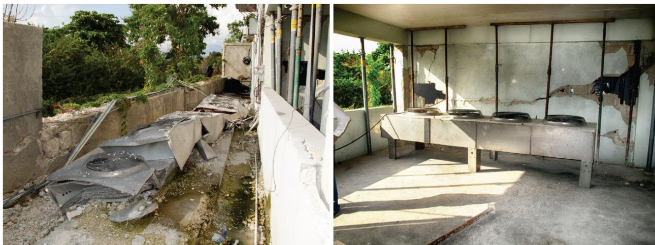
איור 6.4.7.3-7 – יחידות מכניות דוחות חום אשר מספקות קירור לשרתים במרכז רשת סלולרית (בתמונה משמאל). התמוטטות קיר במהלך הרעידה הובילה למעיכת היחידות ולהשבתת תפקודן. יחידות חלופיות זמניות הותקנו בכדי לאפשר למרכז הרשת לתפקד לאחר הרעידה (בתמונה מימין). דוגמה זו ממחישה את חשיבות עיגון המערכות הקריטיות לתפקוד השוטף ומיקומן באזורים לא סמוכים לרכיבים מבניים או לא-מבניים שעלולים ליפול עליהם.
