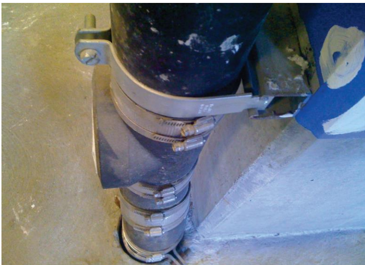
איור 5-6.4.5.2 – דוגמה להתקנה לקיחה של תמיכה בצנרת סניטרית. המרחק של החבק מקצה הקורה התומכת איננו תקין והוא עלול להחליק החוצה.
