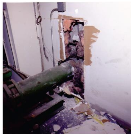
איור 1-6.4.3.8 – נזק שנגרם לתקרות, מחיצות גבס, מגן אש ובידוד. שימו לב כי בצנרת הכחולה נוצרה דליפה שגרמה לנזק נוסף באזור החדירה.
