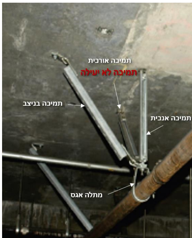
איור 6.4.3.1-7 - עיגון קשיח בניצב ולאורך הצינור, המחובר למתלה אגס. במקרה זה העיגון האורכי אינו יעיל כיוון שמתלה האגס אינו חובק את הצינור, ולכן מאפשר לו להחליק דרכו במקרה של רעידת אדמה בכיוון האורכי של הצינור.
