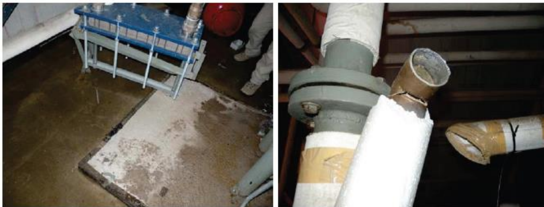
איור 6.4.5.2-1 – שבר בצנרת נחושת להעברת מים חמים. הכשל נגרם עקב תזוזות דוד החימום המוצג מצד שמאל.
