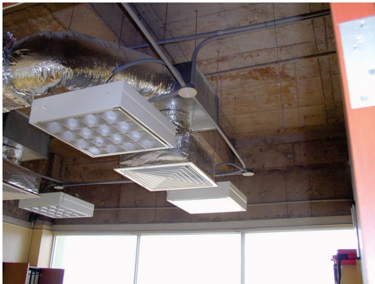
איור 6.4.6.2-2 – מפזרי אוויר שמחוברים לתקרה באמצעות ארבעה מתלים אנכיים. מערכות התקרה נפגמו ברעידה, אך מפזרי האוויר והמנורות לא נפלו. התקרה נהרסה טרם צילום התמונה.
