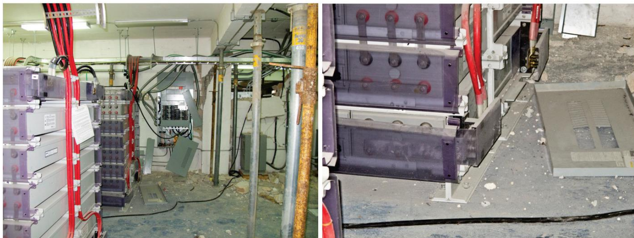
איור 6-4.7.3-6 – חדר סוללות במתקן רשת סלולרית לאחר רעידת אדמה. המבנה בן שלוש הקומות ניזוק מאוד ברעידה ועבר הריסה ובנייה מחדש. שימו לב לטיגון הקשיח של הסוללות המאסיביות שלא נפגעו תפקודית במהלך הרעידה, על אף שהמבנה ספג הזזות גדולות שגרמו לגזירת העמודים התומכים.
