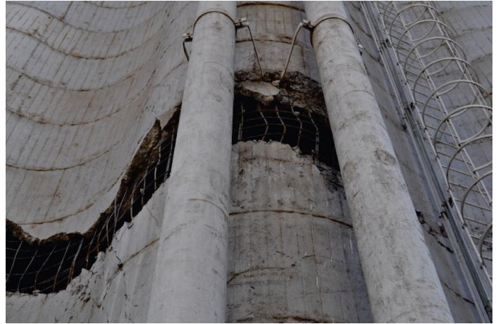
איור 2-6.4.3.7 – עיגון צנרת לקיר סילו ניזוק. למרות הנזק המבני שנגרם לסילו, עיגון הצנרת היצוק באתר נותר שלם והצינורות לא נפלו.
