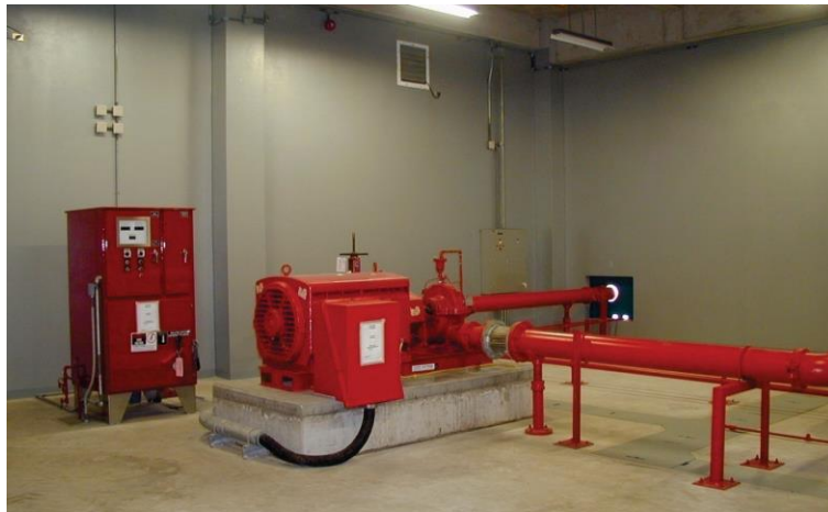
איור 6.4.4.1-8 – לא נגרם נזק כלשהו למערכת כיבוי האש בחדר בקרה זה, תודות לעיגון תקין של המשאבה ולוחות הבקרה, לחיבורים גמישים בצנרת עם פתח חדירת קיר בגודל תקין ולמניעת סכנת נפילה.
