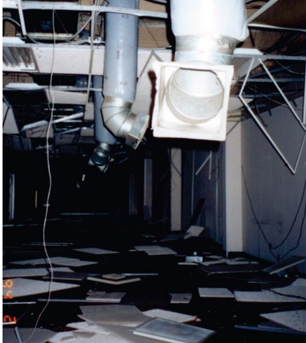
איור 6.4.6.2-1 – מפזרי אוויר שנפלו מהתקרה ותעלות תלויות שהשתחררו מרשת התקרה.
